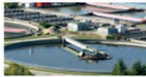
Traitement et Réutilisation des eaux usées
